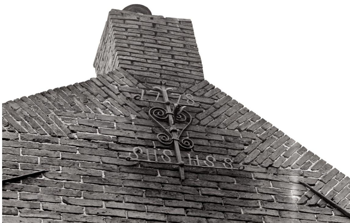
Muuranker in de oostelijke zijgevel van Erve Heilcke uit 1778. Aangebracht door Simon Harms Strating en Harm Simons Strating.
