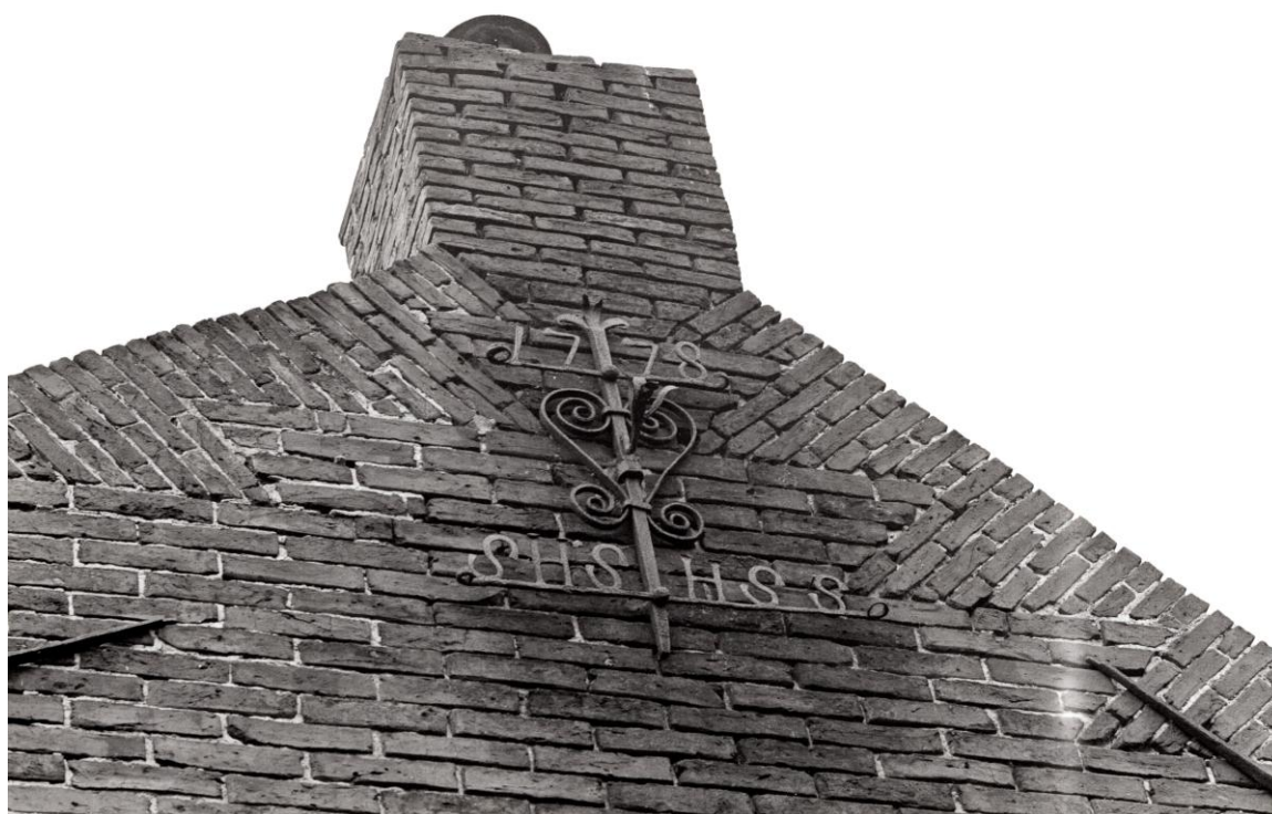
Muuranker in de oostelijke zijgevel van Erve Heilcke uit 1778. Aangebracht door Simon Harms Strating en Harm Simons Strating. Rijksarchief Groningen.
